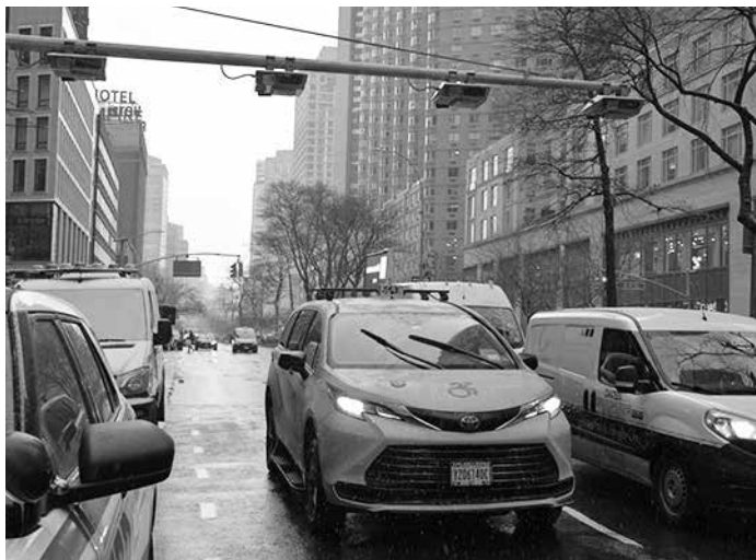
ナンバー自動認識装置が設置された道路(市内60丁目交差点)
